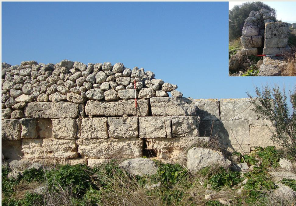
Fig. 2 – Paramento esterno di II fase con blocchi di testa e per lungo addossato alla cortina di I fase con blocchi disposti per lungo (tratto E). In alto a destra, sezione della fortificazione.
