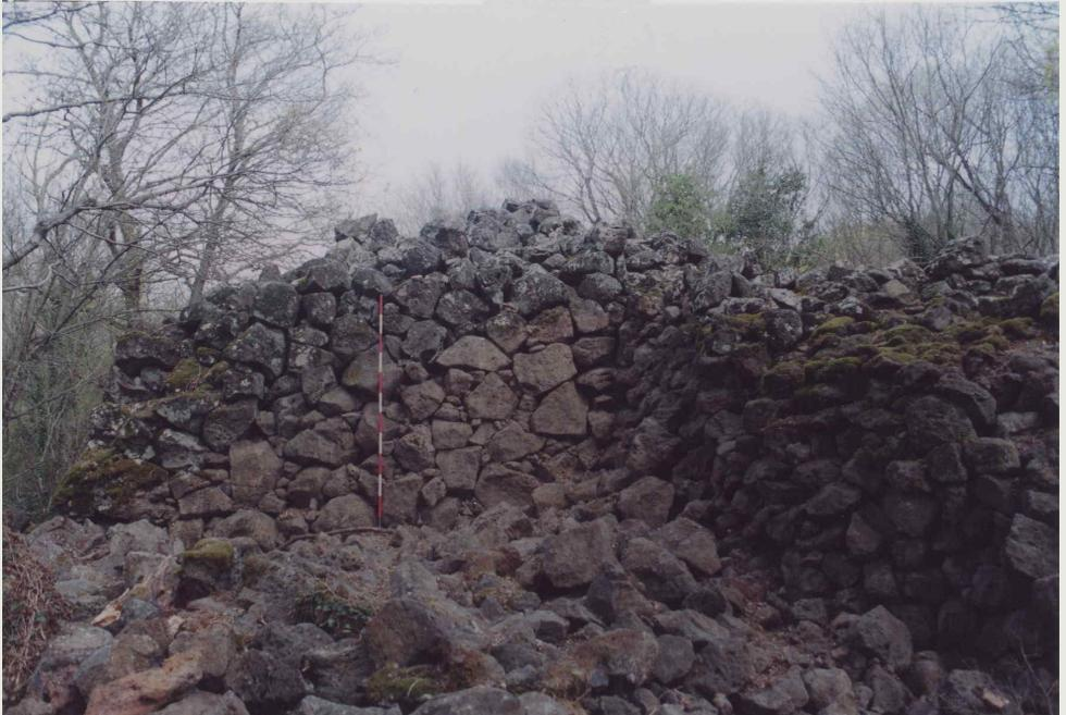
Fig. 3 – Il lato sud-ovest della torre occidentale: è evidente la tecnica costruttiva in rozza opera poligonale.
